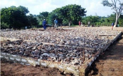
Gebäude-Bodenplatte wird vorbereitet
